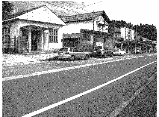
事故現場の現在。向かって右側が会津方面。
